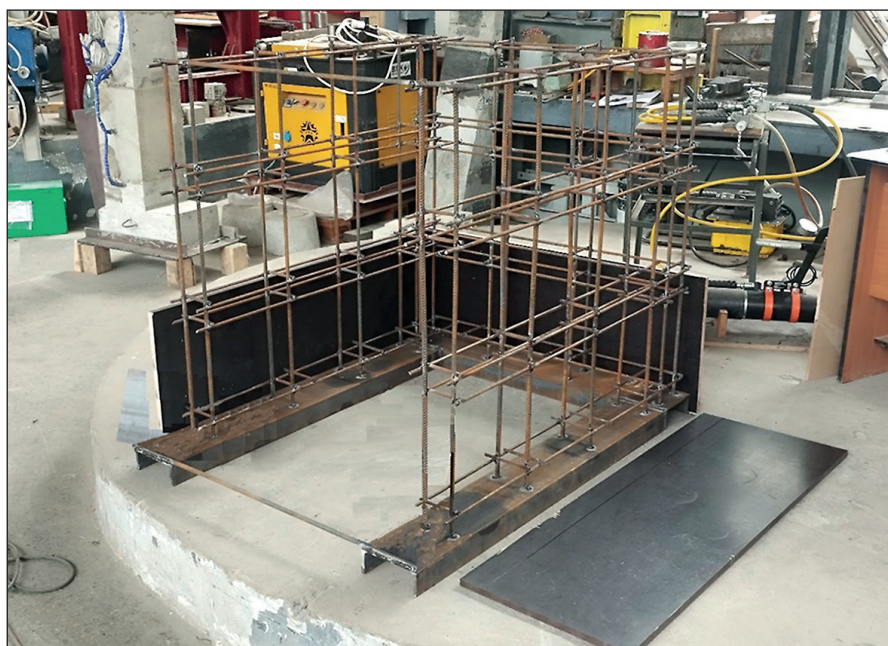
Рис. 7. Пространственный арматурный каркас железобетонных моделей с устанавливаемой опалубкой 1-го яруса бетонирования
