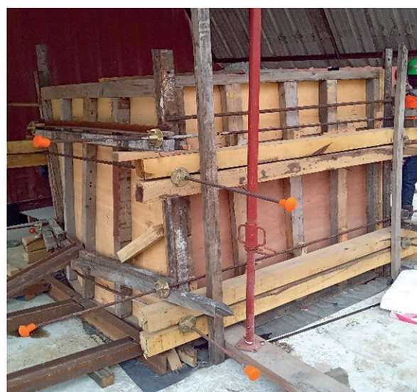
Рис. 7. Слева: кубический образец DEF размером 1×1×1 м 3 , справа – кубический образец DEF размером 1,6×1,6×1,6 м 3
