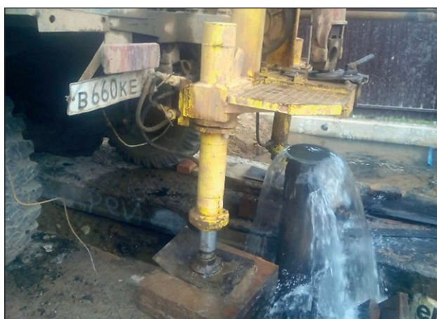
Рис. 6. Скважина на стадии ремонта, 2016 г.
