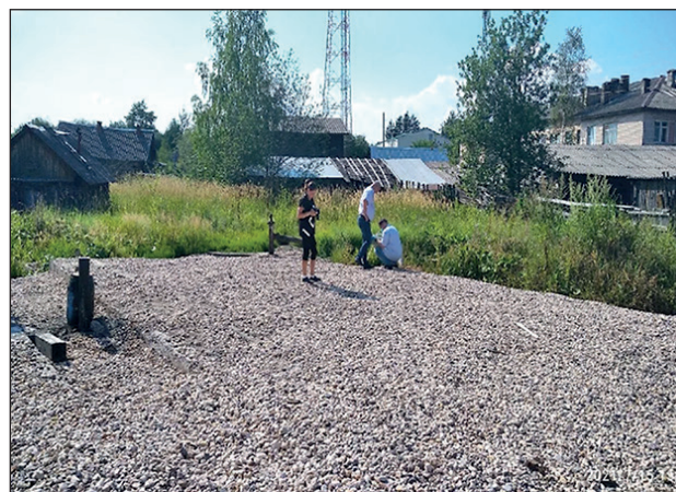
Рис. 5. Участок после ликвидации скважины
