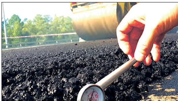
Рис. 5. Контроль укладки асфальтобетонного дорожного покрытия с использованием полимерно-битумных наноконпозиций
