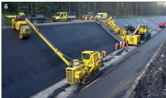
Рис. 1. Оросительные каналы, облицованные асфальтобетонным покрытием: а – Альц-канал, Германия; б – канал Святого Панталеона, Австрия
