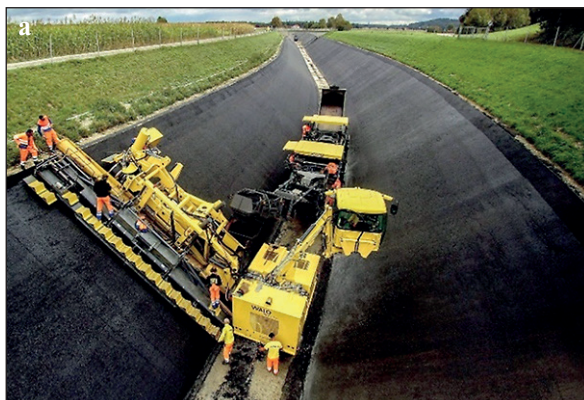
Рис. 1. Оросительные каналы, облицованные асфальтобетонным покрытием: а – Альц-канал, Германия; б – канал Святого Панталеона, Австрия
