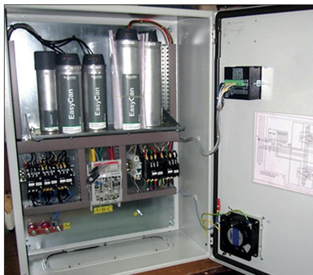
Рис. 9. Конденсаторный компенсатор реактивной мощности (ККРМ)
