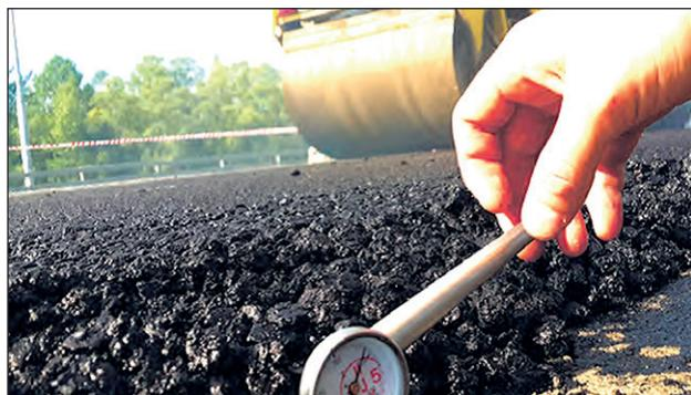
Рис. 5. Контроль укладки асфальтобетонного дорожного покрытия с использованием полимерно-битумных нанокомпозиций
