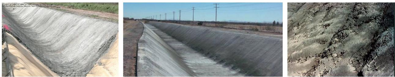
Рис. 1. Опытные участки торкретной облицовки оросительных каналов на юге Казахстана
