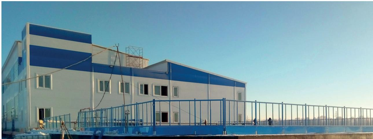
**«Нанотехнологический центр композитов» («НЦК»), акционером которого является Фонд инфраструктурных и образовательных программ РОСНАНО, разработал и начал производство специальных композитных перильных ограждений из стеклопластика. Пилотный проект реализован в Ярославле на птицефабрике «Ярославский бройлер» в ходе реконструкции аэротенков очистных сооружений.**
